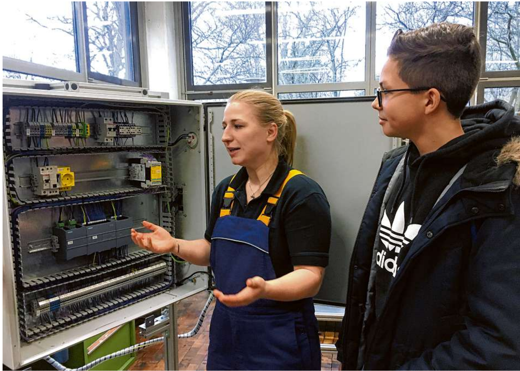
Hannah erklärt Moritz den Aufbau des Schaltkastens, den sie zu ihrer Abschlussprüfung vorführen muss
