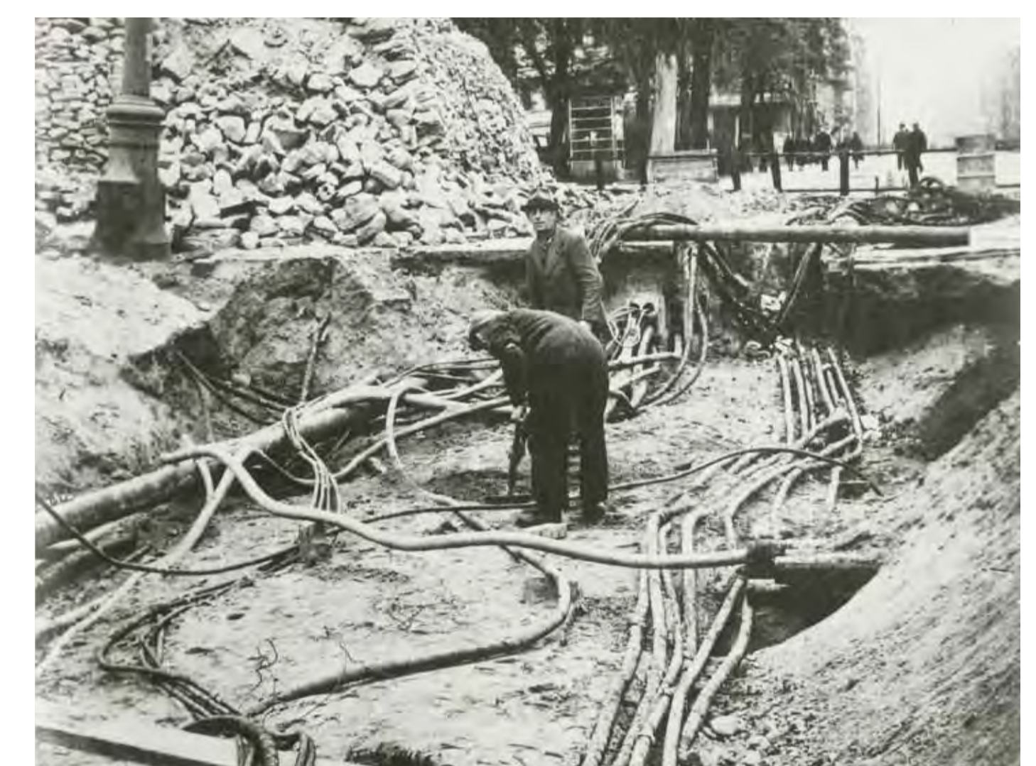
Reparaturarbeiten an durch den Krieg beschädigten Kabeln, 1954
