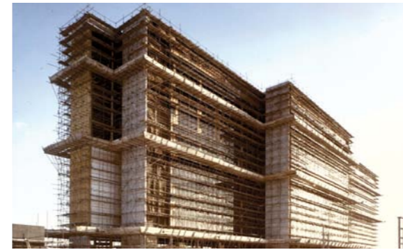
Bau des Verwaltungsgebäudes in der City Nord
