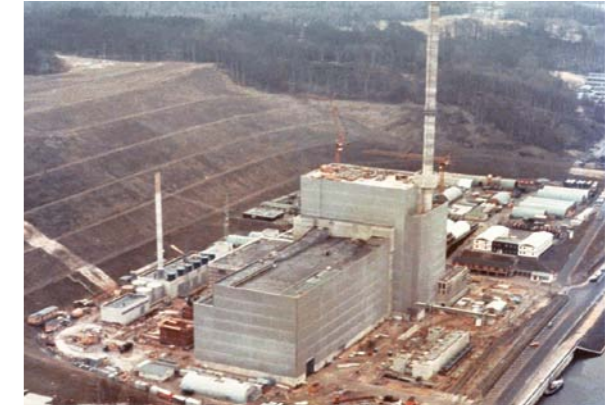
Luftbild des Kernkraftwerks Krümmel während der Errichtung
