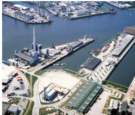
Das alte Kraftwerk Hafen und das neue Heizwerk HafenCity vor der Demontage des alten Kraftwerks
