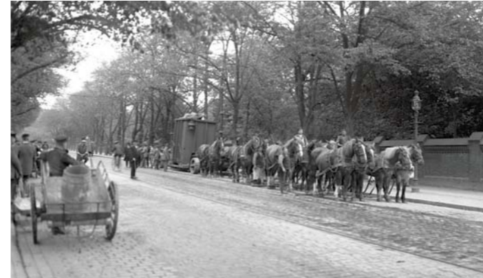
Transport eines Transformators
