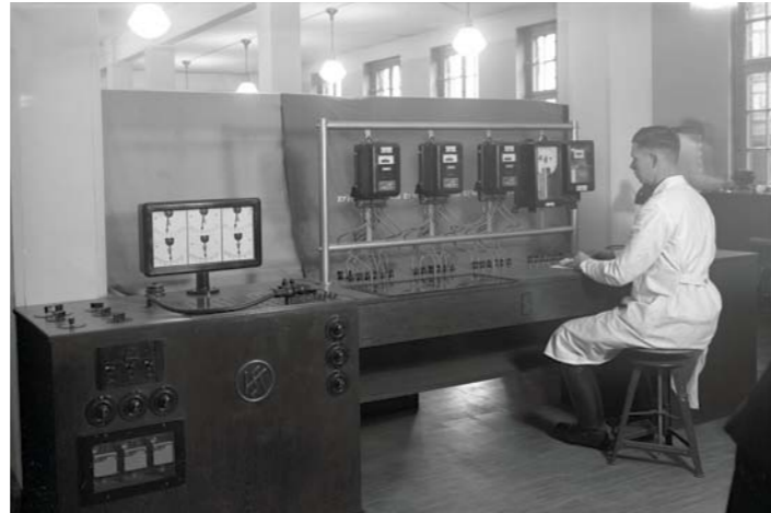
Prüfung der Stromzähler
