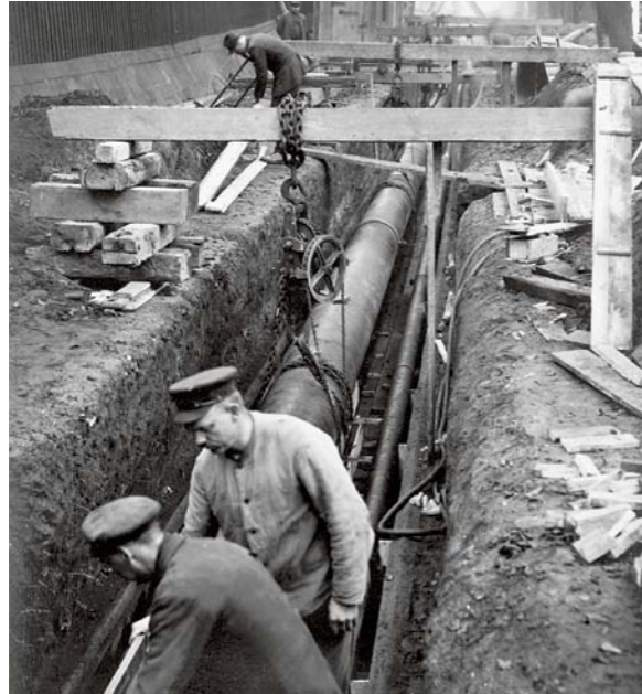
Verlegung einer Fernwärmeleitung, 1929
