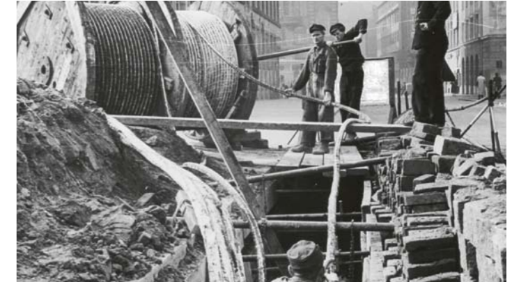
Kabelverlegung in der Hamburger Innenstadt
