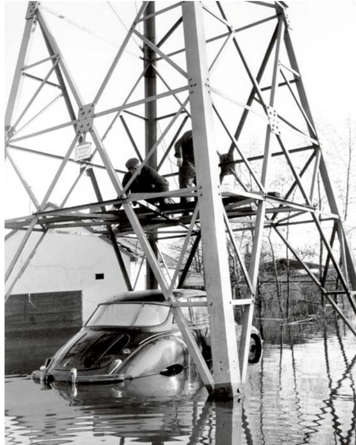
Leitungskolonne im Einsatz während der Sturmflut 1962
