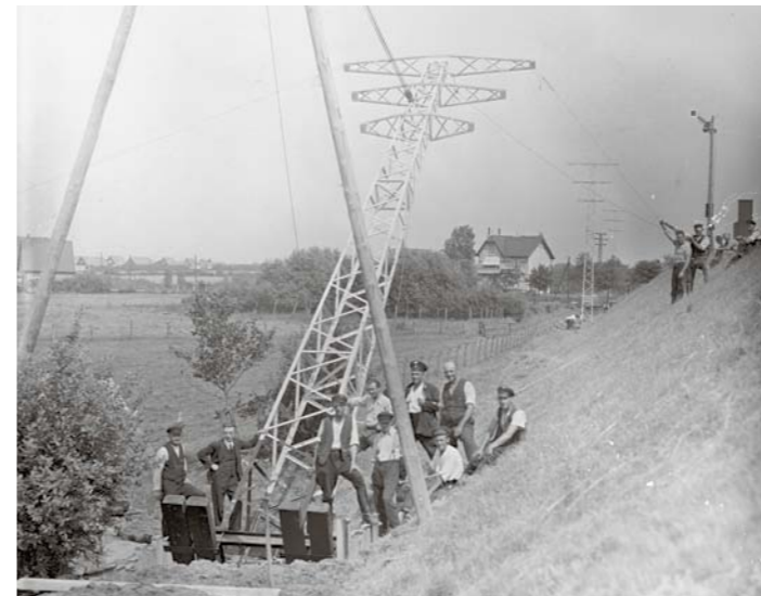
Aufrichten eines Freileitungsmastes
