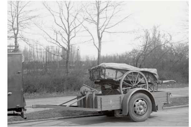
Schott'sche Karre für den Transport von Werkzeug und Material bei Kabelarbeiten
