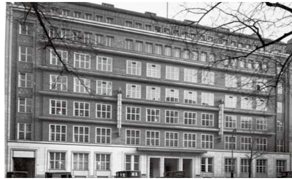
Verwaltungsgebäude Ende der 1920er-Jahre
