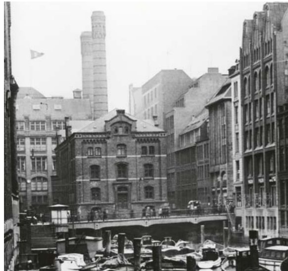
Hamburgs erstes Elektrizitätswerk in der alten Stadtwassermühle, Poststraße
