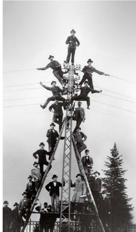
Richtfest einer Niederspannungsleitung
