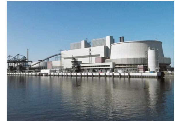
Ansicht des neuen, derzeit in der Fertigstellung befindlichen Kraftwerks Moorburg
