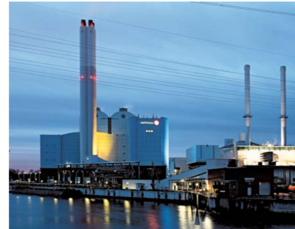
Das heutige Heizkraftwerk Tiefstack
