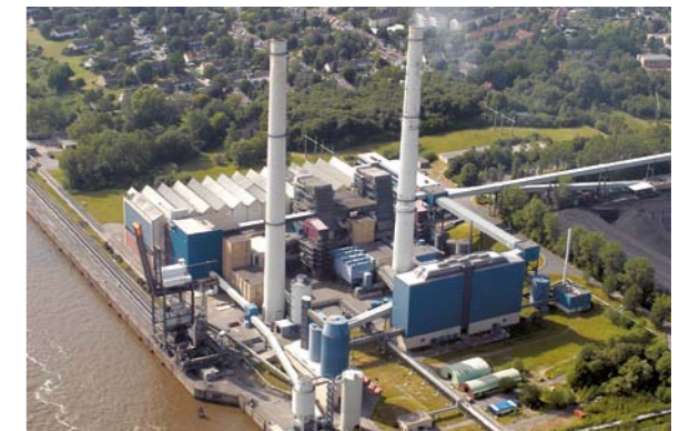
Luftbild des Heizkraftwerks Wedel
