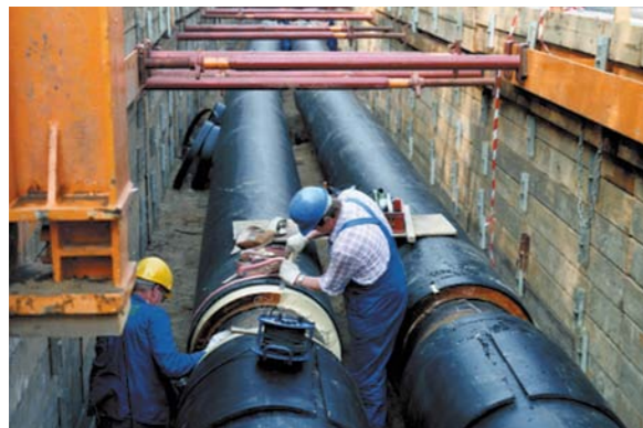
Bau einer Fernwärmeleitung, um 1990
