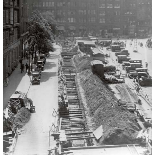
Ausbau der Fernwärme in der Hamburger Innenstadt
