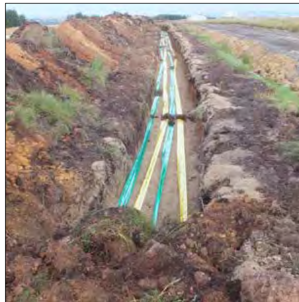
Figur 2.8. Eksempel på kabelgrav med markeringsbånd over kablerne.
