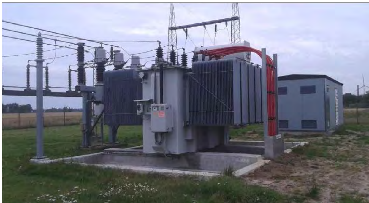
Figur 2.5. Mulig udformning af 60 kV transformerstation i projektområdet.
