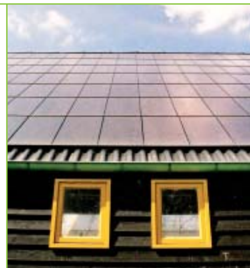
Detailopname van de zwarte zonnepanelen op de potstal van Natuurmonumenten in Eelde.
