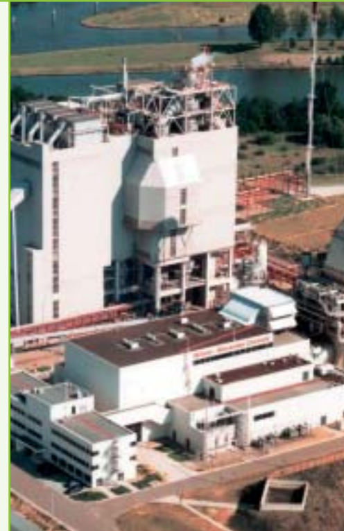
Met de centrale in Buggenum beschikt Nuon over een kolenvergassingsinstallatie, die op een schonere manier dan normale kolencentrales elektriciteit opwekt.
