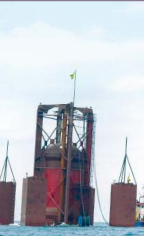
Links: mislukte afzinkpoging van de Archimedes Wave Swing voor de kust van Portugal.
