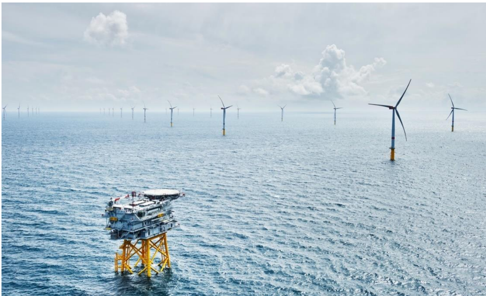
Figur 7. Exempel på utformning av transformatorstation med fackverksfundament.
