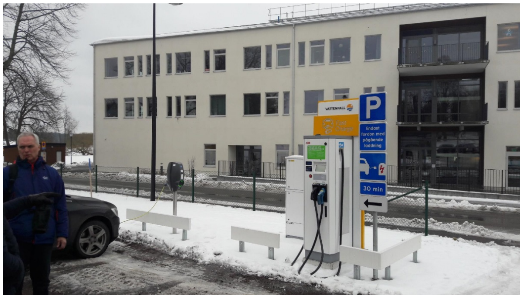
Bild 7 Laddstation med tillhörande parkeringsskylt
