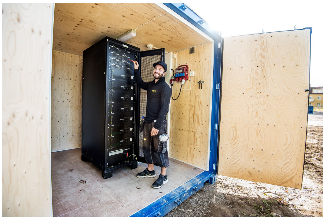
Bild 5 Batterilagret i sin container
