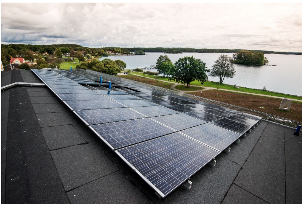
Bild 3 Del av solcellsanläggningen
