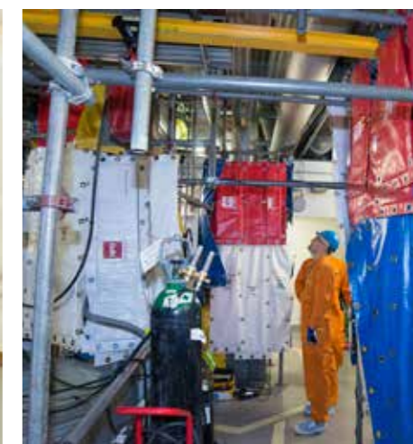
För att skapa en god arbetsmiljö används blymattor som strålskärmar vid ombyggnaden av säkerhetsventiler på Ringhals 2.
