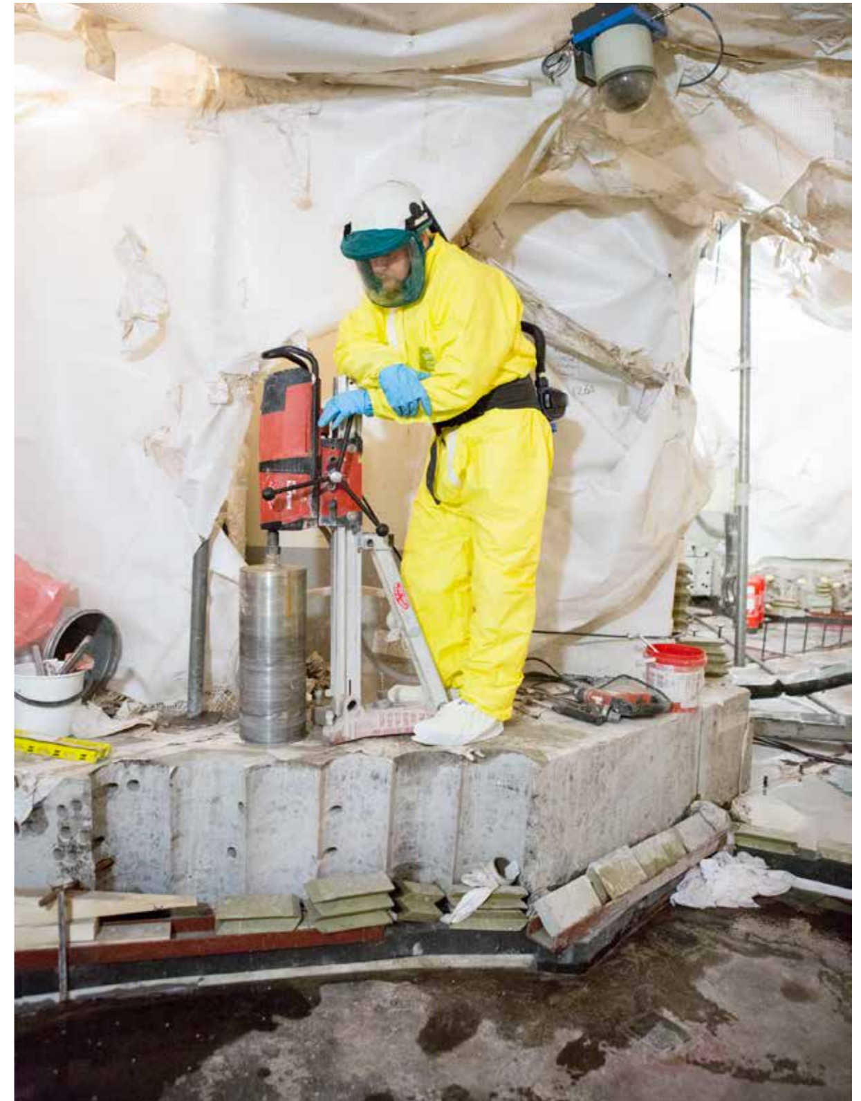
Bottenplåten frilades genom att det överliggande betonglagret borrades upp och sågades i bitar.
