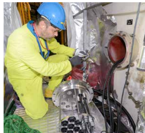
Under revisionen drogs kablar av högre miljöklass från relärummen till kopplingslådor i reaktorinneslutningen.
