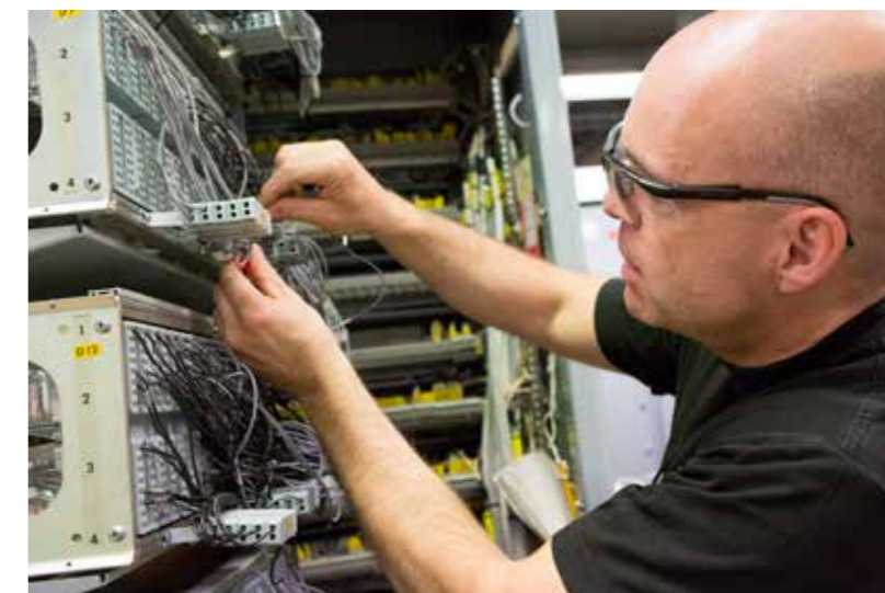
I relärummet byttes ett stort antal automatsäkringar.
