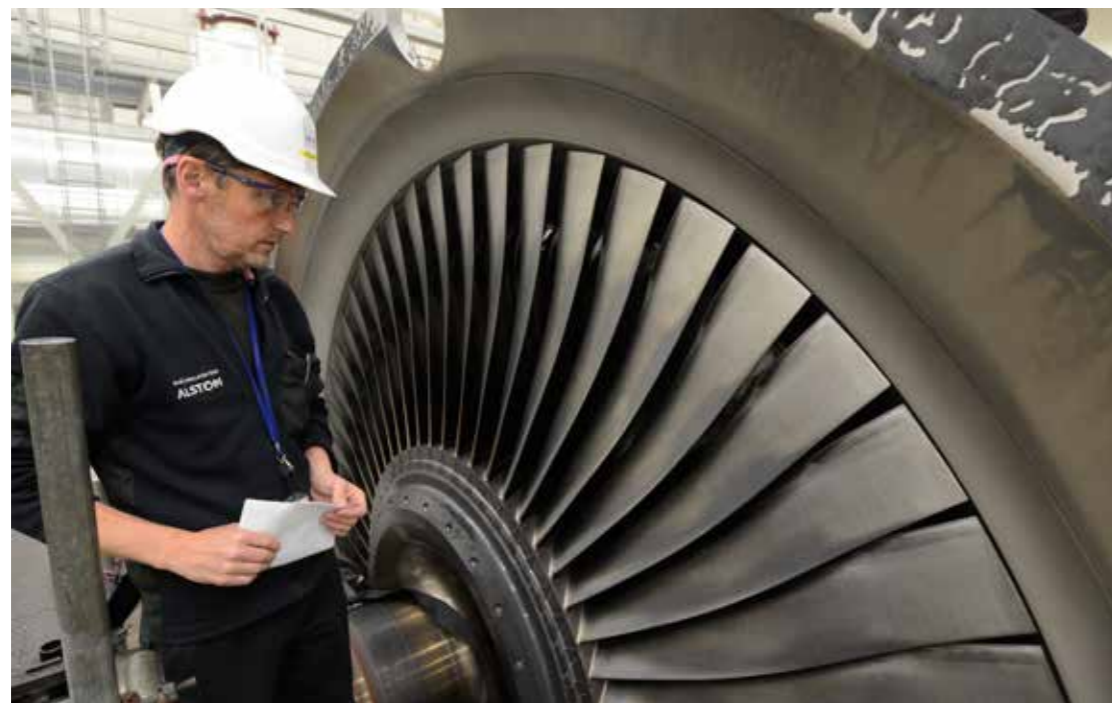
Lågtrycksturbinerna på den ena turbinsträngen demonterades så att skovelblad och infästningar kunde inspekteras.
