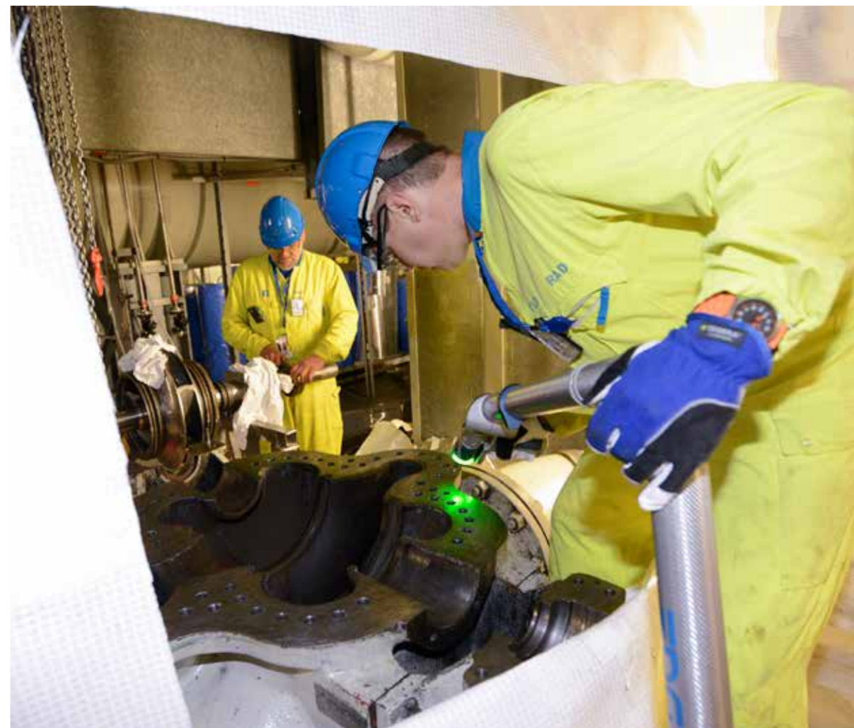
Med hjälp av ett precisionsverktyg mäts att ett pumphus i reaktorns kylsystem monteras så exakt som möjligt.
