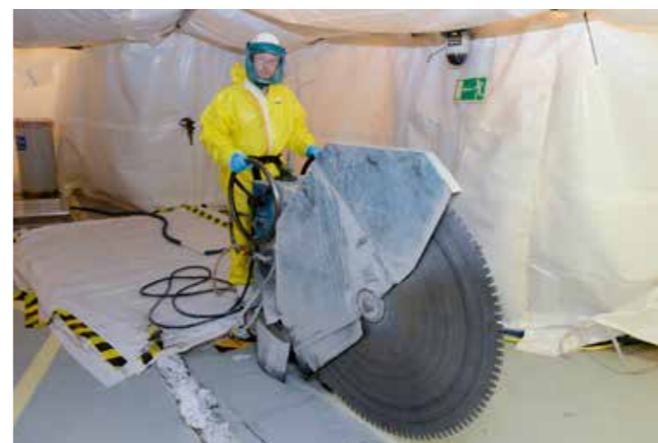
I reaktorinneslutningen sågades betonggolvet och lecablock upp med en stor såg för att frilägga den underliggande bottenplåten.
