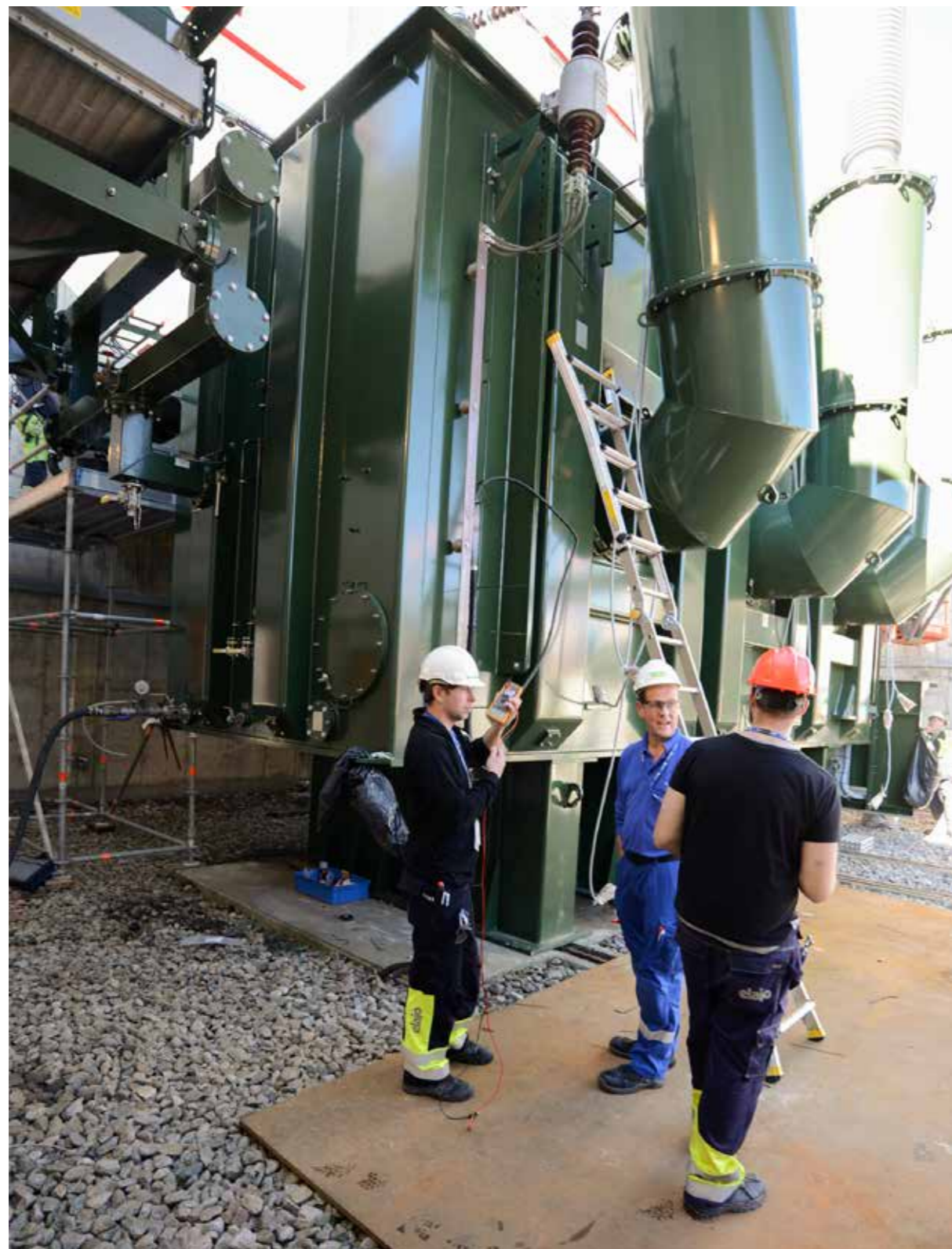
En ny huvudtransformator installerades på Ringhals 2, vilket bland annat innebär en sänkning av bullernivån till omgivningen. Totalt väger transformatorn 370 ton.
