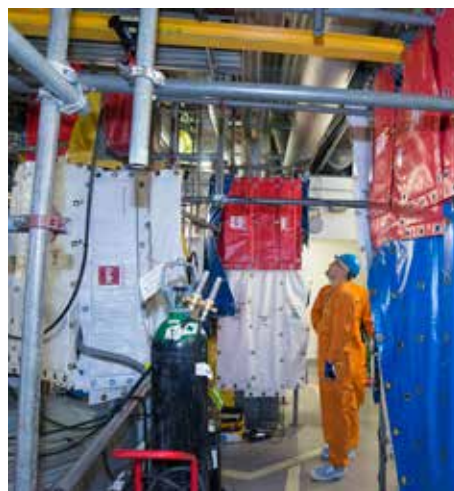
För att skapa en god arbetsmiljö används blymattor som strålskärmar vid ombyggnaden av säkerhetsventiler på Ringhals 2.
