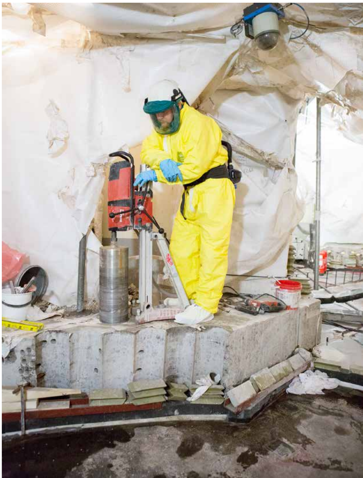
Bottenplåten frilades genom att det överliggande betonglagret borrades upp och sågades i bitar.
