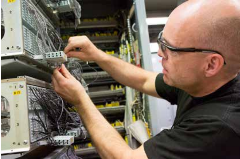
I relärummet byttes ett stort antal automatsäkringar.
