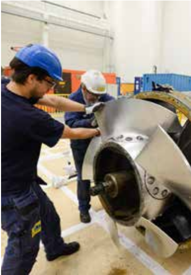
Underhållsarbete på en kylvattenpump som bland annat får nya gummipackningar.
