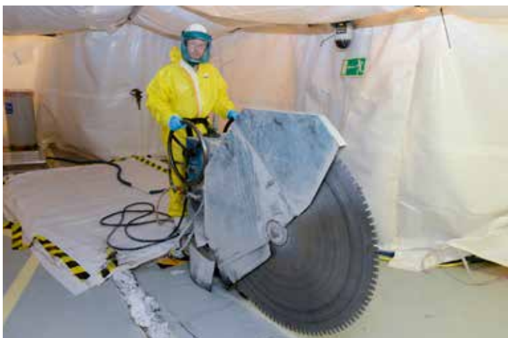
I reaktorinneslutningen sågades betonggolv och lecablock upp med en stor såg för att frilägga den underliggande bottenplåten.
