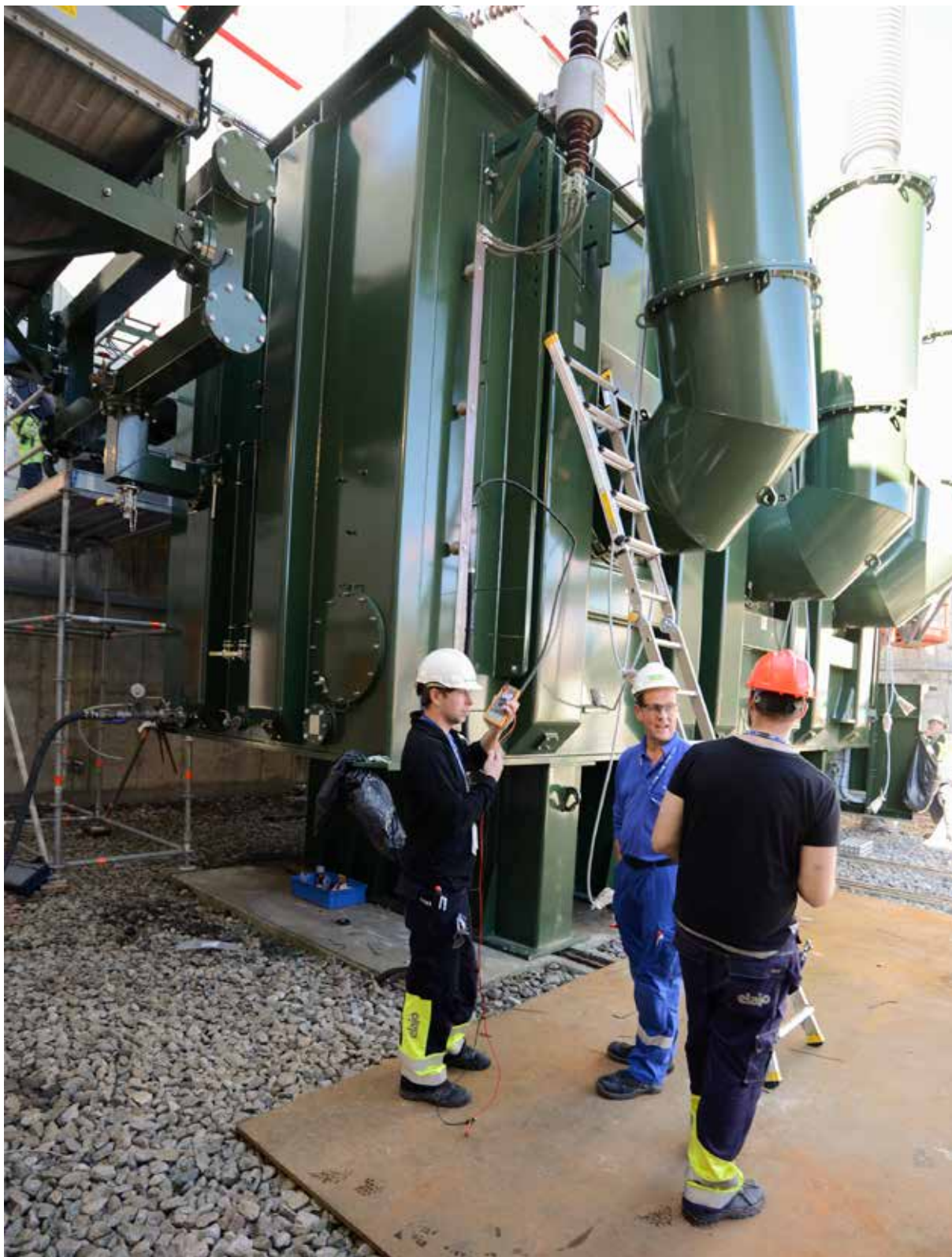
En ny huvudtransformator installerades på Ringhals 2, vilket bland annat innebär en sänkning av bullernivån till omgivningen. Totalt väger transformatorn 370 ton.
