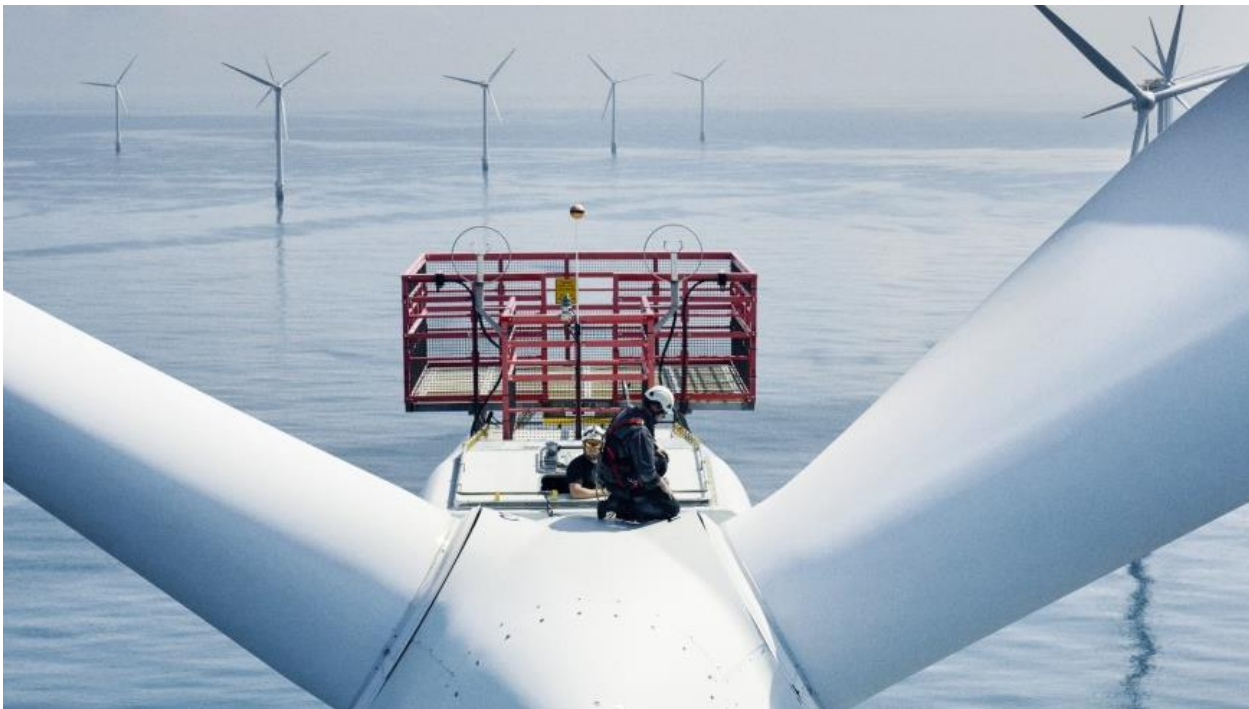
Horns Rev 1 vindkraftverk, Danmark
