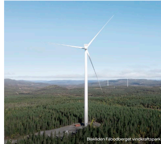
Blakliden Fäbodberget vindkraftspark
