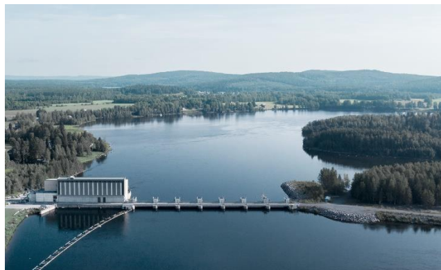
Vittjärv vattenkraftverk i Sverige
