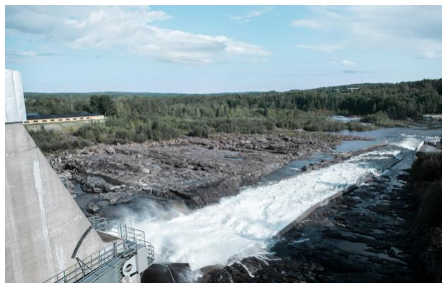
Stornorrfors vattenkraftverk i Sverige
