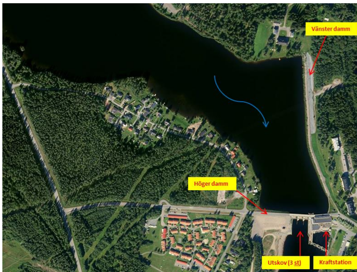
Figur 2 Översikt Bodens kraftstation.
