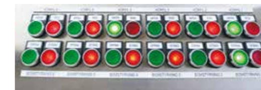
Kontrollstation för bommar och signallampor. I vaktkuren med skottsäkra glas och väggar arbetar alltid minst två skyddsvakter. Foto: Eva Fischer
