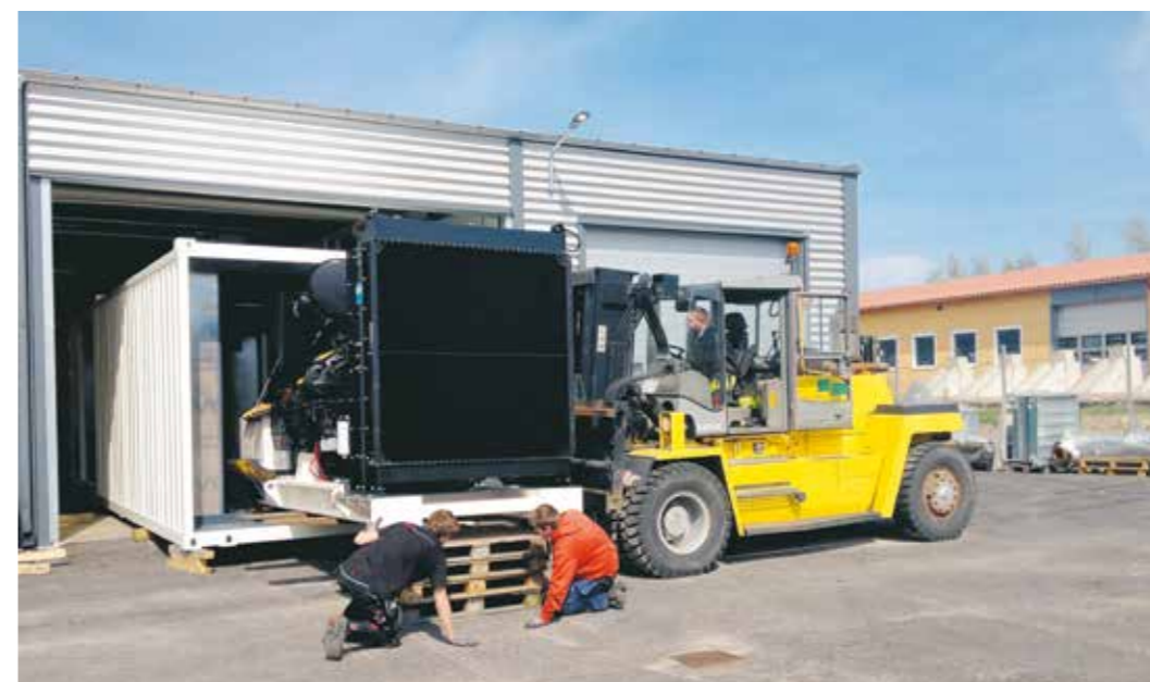
Nya mobila dieselmotorer levereras till Forsmark under sommaren. De är ett komplement till befintliga system med uppgift att säkra kraftförsörjningen till anläggningen. Foto: Anders Nilsson
