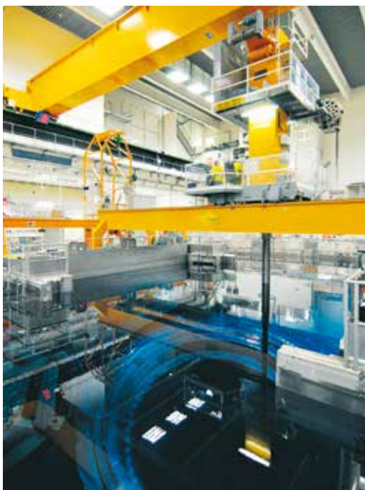
116 bränslepatroner byttes ut mot nya när Forsmark 1 hade revision. Bränslebytet görs under vatten med hjälp av en så kallad laddmaskin. Foto: Alexander Åberg
