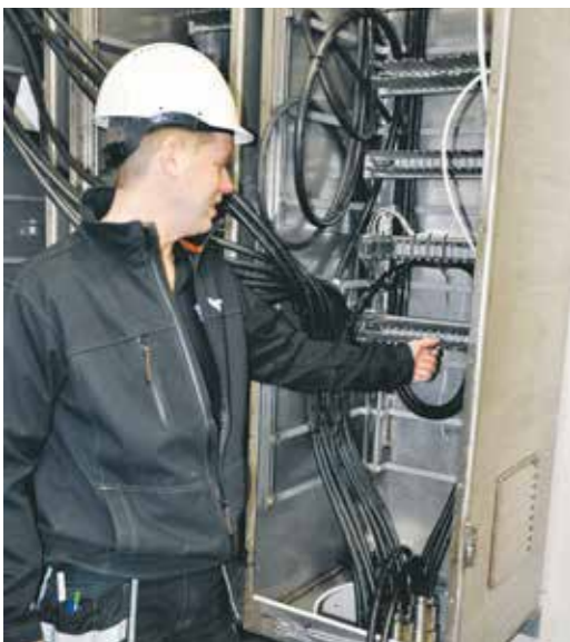
Arbetsledaren Mats Österman visar kabelgenomförings-skåpen i modellen av reaktorinneslutningen på Forsmark 3. Kabelgenomförings-skåpen ska, tillsammans med genomföringsmodulerna och genomföringsrören, bytas ut mot nya under årets revision. Foto: Alexander Åberg
