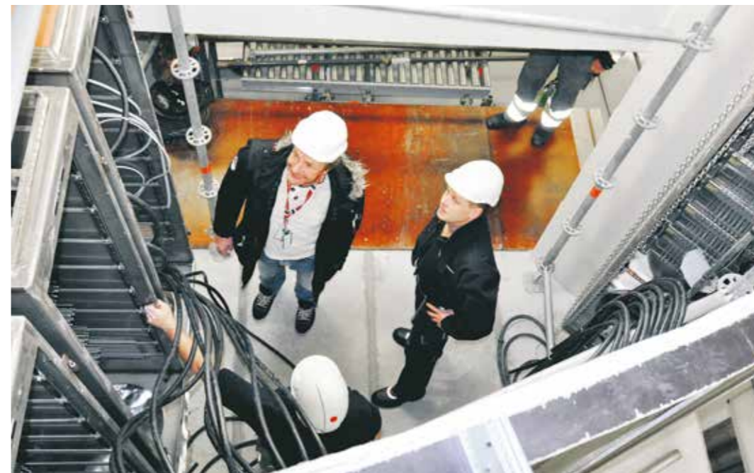
Montagesamordaren Björn Jansson och arbetsledarna Mats Österman och Jan Joons går igenom arbetsmoment i modellen av reaktorinneslutningen på Forsmark 3. Modellen står på okontrollerat område och används för att öva arbetsmoment inför Forsmark 3:s revision. Foto: Alexander Åberg
