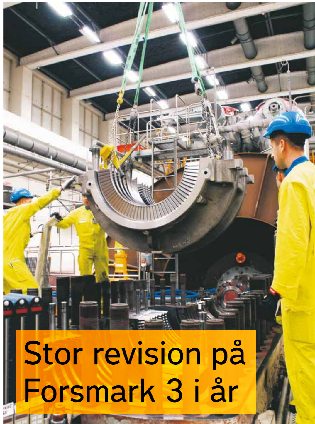
Högtrycksturbinen på Forsmark 1 byttes ut 2011. Under sommarens revision på Forsmark 3 ska motsvarande arbete utföras. En ny högtrycksturbin klarar av ett större ångflöde vilket förbereder anläggningen för en framtida effekthöjning. Foto: Elin Bergqvist
