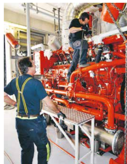
Under revisionen på Forsmark 1 i april och maj utfördes underhållsarbete på hjälpkraftdieslaggregaten. Tony Karlsson bistår Andreas Lindfors som letar efter sprickor i dieselmotorn. Foto: Alexander Åberg
