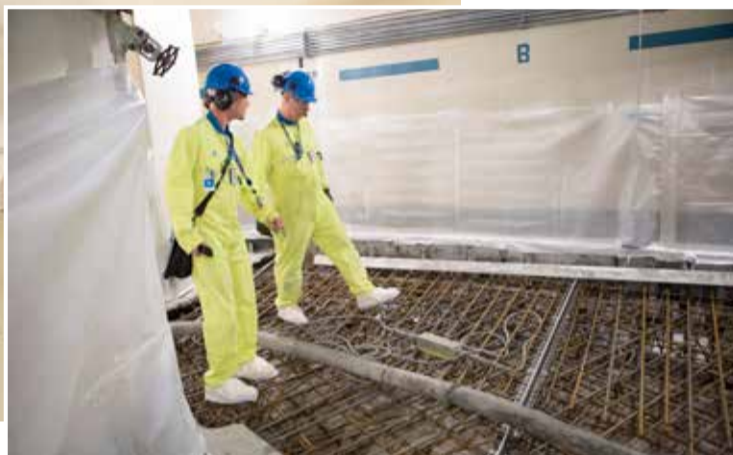
Ny plåt svetsades på de ytor där skador fanns i den underliggande plåten. Därefter återställdes armeringen innan det var dags att gjuta nytt golv och täthetsprova den totalt 800 kvadratmeter stora byggnaden.
