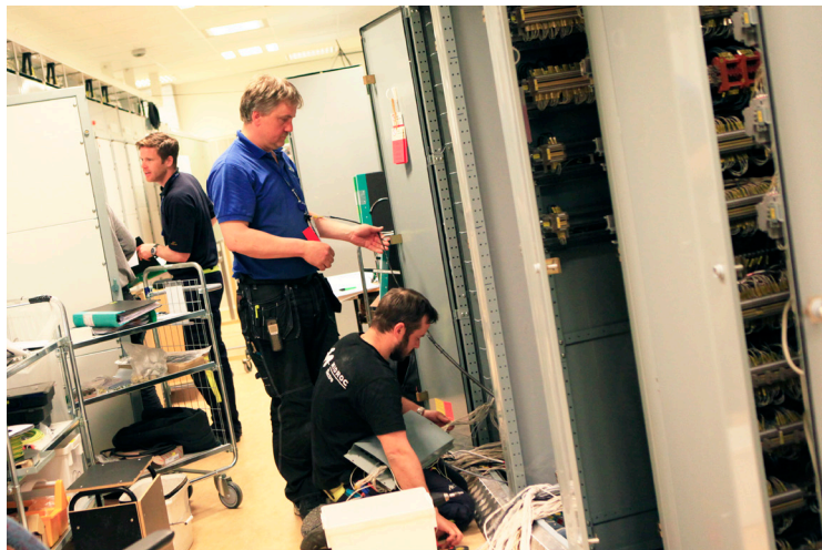
Under revisionen 2013 genomfördes flera stora arbeten. Här flyttas kontrolltavlor i kontrollrummet i Ringhals 1 fram. Ett projekt som sträckte sig över 20 dygn.
