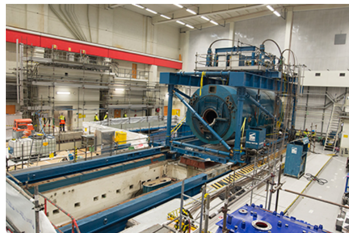
Byte av generator på R1 2015
