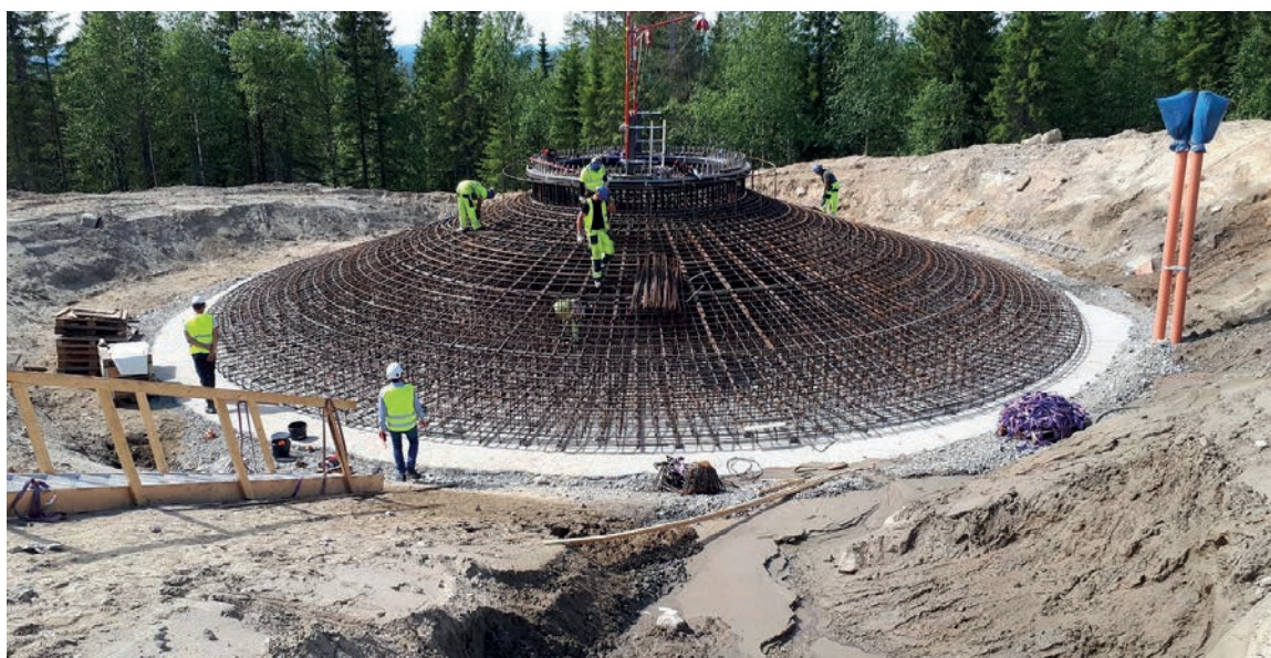
Ett gravitationsfundament under uppbyggnad. Gravitationsfundament används där jorddjupet är större och fundamentet i sig blir en motvikt till vindkrafterna. Foto: Vattenfall
