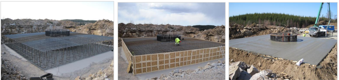
Figur 51 Gravitationsfundament under uppförande. Foto: Vattenfall.
