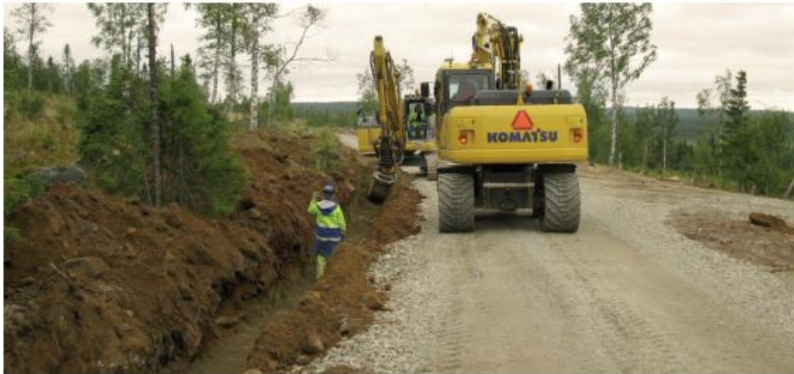
Figur 59 Grävning av kabeldike. Källa: Vattenfall MKB Stormyrberget
