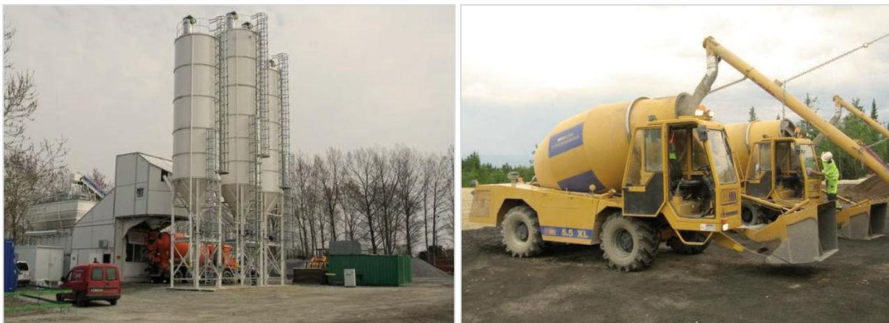
Figur 61 Exempel på en temporär betongframställning till vänster och mobila betongblandare till höger. Foto: Vattenfall.
