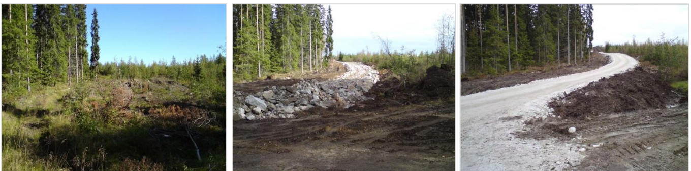
Figur 52 Exempel på anläggandet av en väg inom en vindkraftpark, illustrerat i tre steg. Bild till vänster visar före, bild i mitten är anläggningsskedet och bild till höger är den färdiga vägen. (Foto: Jörgen Glemme, Triventus Wind power AB)
