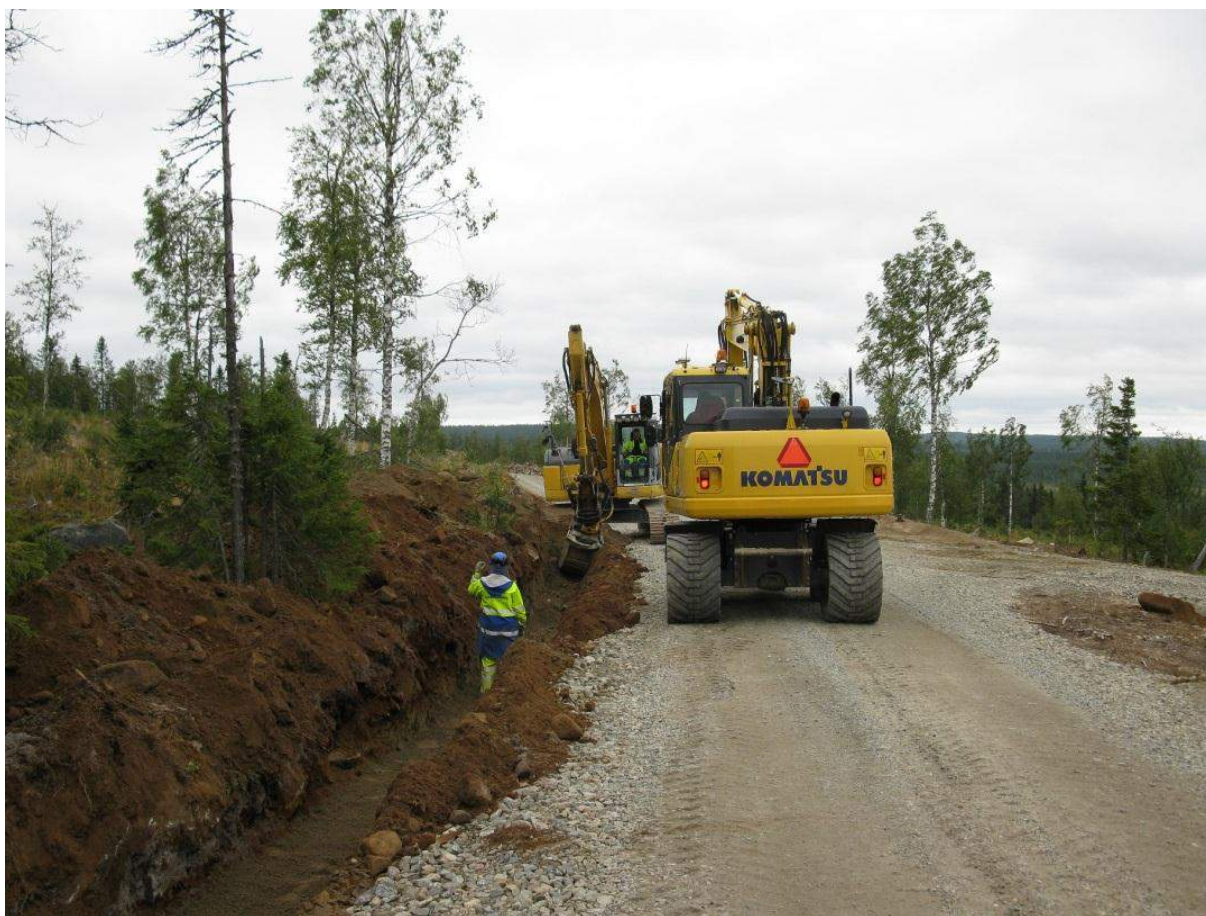
Figur 5:14. Grävning av kabeldike
