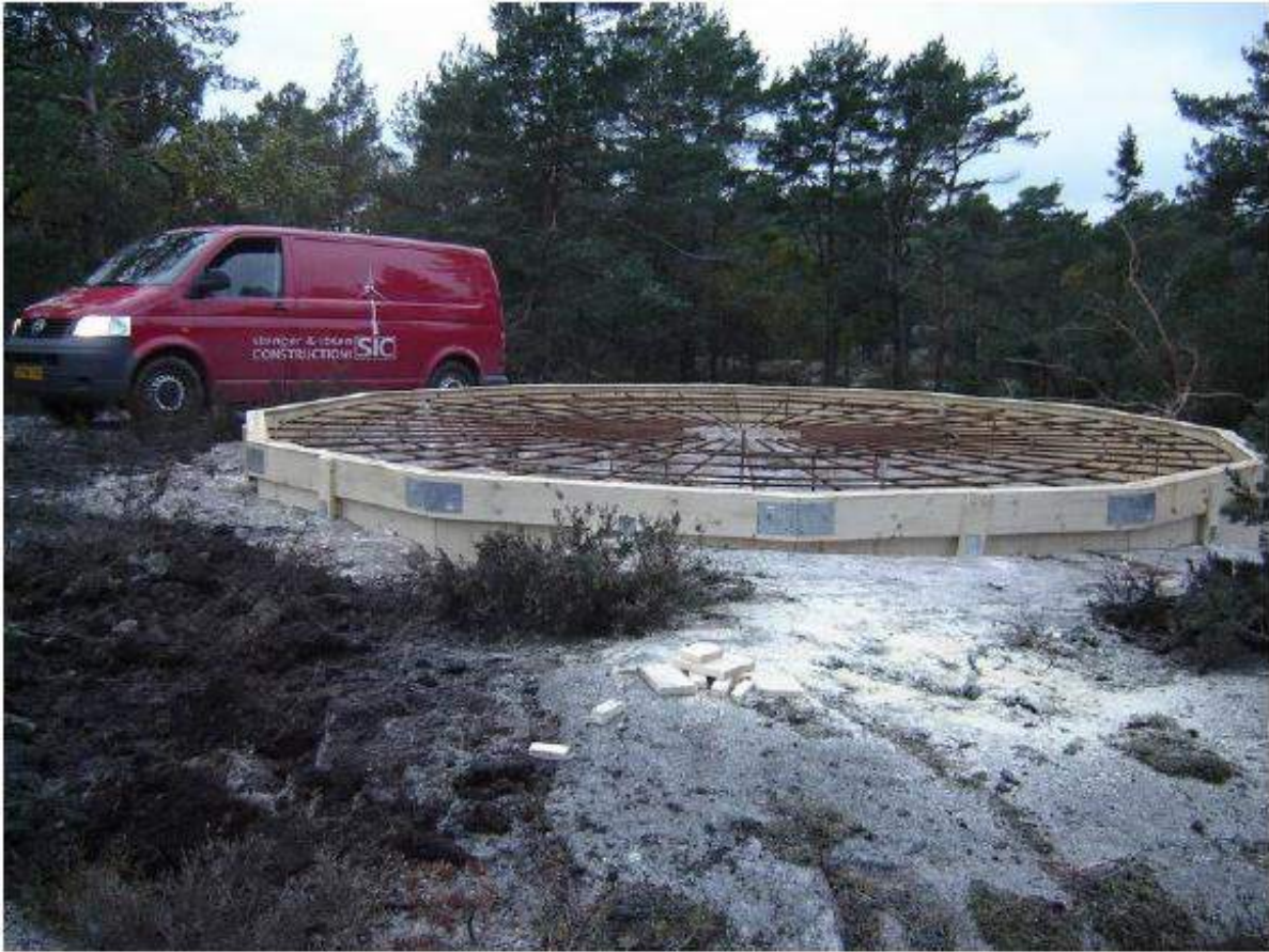
Figur 5:4. Bergförankrat fundament
