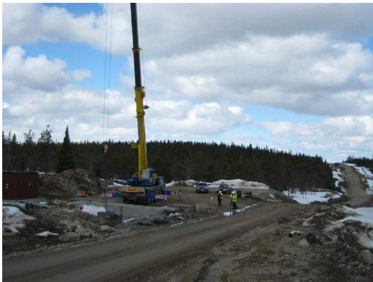
Figur 5:13. Exempel på montageplats och väg
