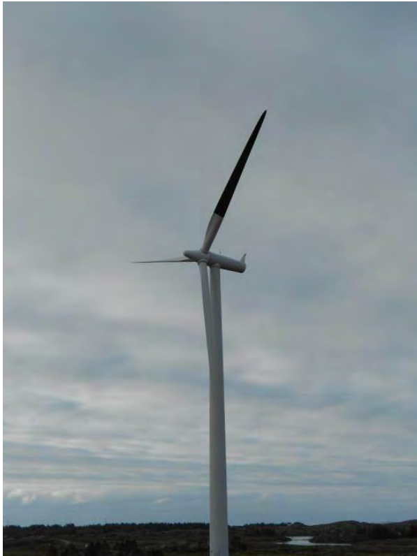
Figur 29. Fotomontage på vindkraftverk med ett av tre blad målat svart som åtgärd för att minska risken för fågelkollisioner, se Bilaga 14 e.
